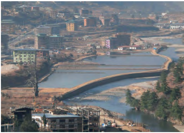
写真-3 プータンの既存の汚水処理施設
