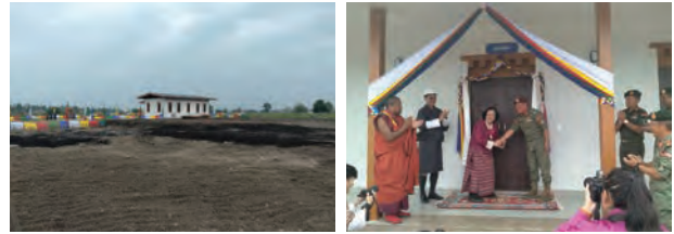
写真-5 ゲルスン学園での土壌浄化法の工事
